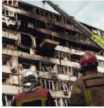
Des secouristes du SUE près d'un immeuble civil endommagé lors d'une attaque combinée menée par des missiles russes et des drones à longue portée contre Kyiv le 25 novembre 2025, qui a fait sept morts et 21 blessés. Source : Pavlo Petrov, porte-parole du SUE de Kyiv.
